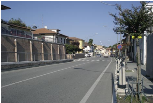
Montecchio - Sant'Angelo in Lizzola, corso XXI Gennaio
